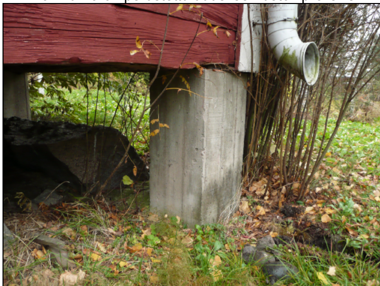
Alue jolle suunniteltu rakennusala sijoittuu. Kuvattu itään. Alla: Huvila on perustettu uudelleen betonipilareille.
