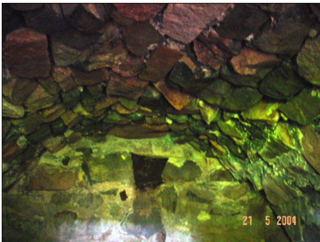
Sisäkuva vanhemman kellarin holvauksesta
